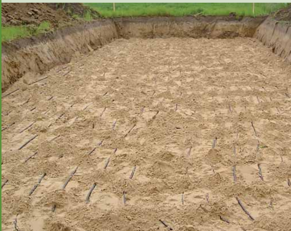
Verlegung der Leitungen für Erdwärme-Flächenspeicher im Fundamentuntergrund.
